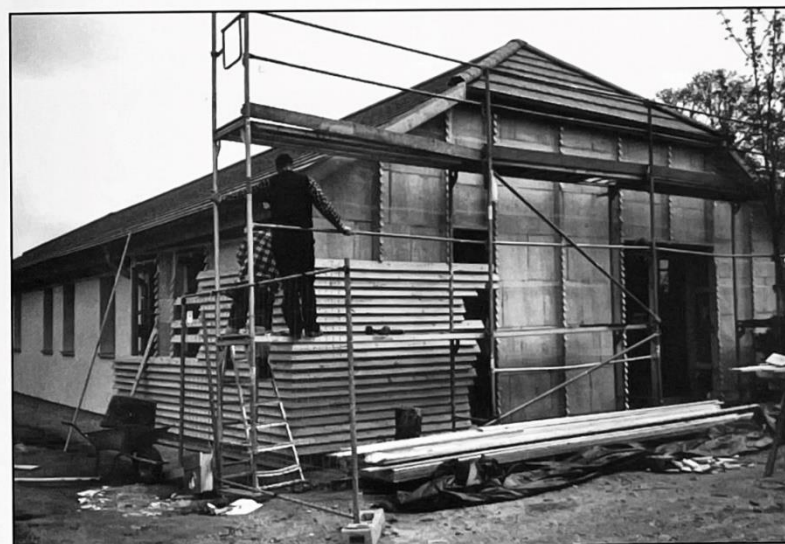
Abb. 9: Vorgehängte Fassade mit Lamellen aus Lärchenholz.
