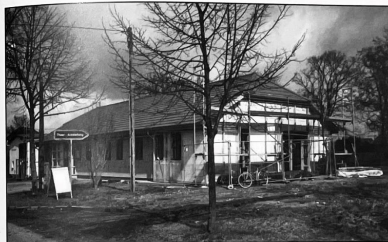
Abb. 8: Die Baracke ist neu bedacht.
