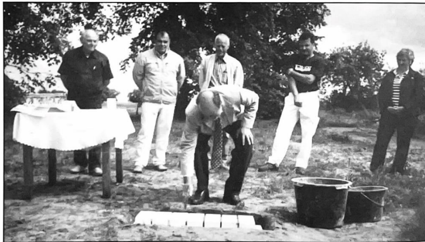
Abb. 11: Die Grundsteinlegung. Von links nach rechts: Geschäftsführer Scholz von der La-Ge-Bau GmbH Wriezen als Vertreter des Bauhauptgewerbes, Amtsdirektor Dr. Ehling, Geschäftsführer der Fördergesellschaft Prof. Frielinghaus, Bauleiter Stegemann, Ortsteilbürgermeisterin Zahn und der Vorsitzende der Fördergesellschaft Prof. von Oppen beim Hammerschlag.
