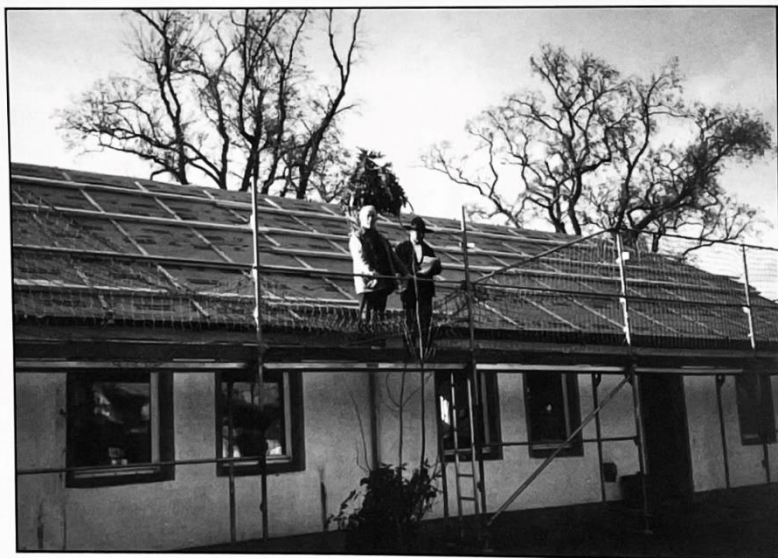
Abb. 7: Richtfest des 1. Bauabschnitts.
