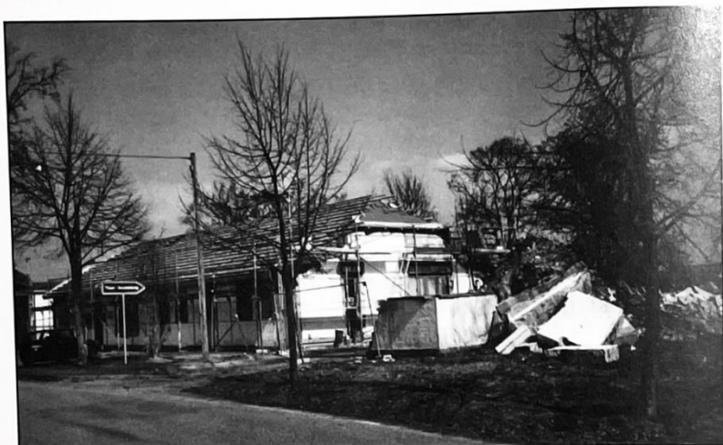
Abb. 6: Abriss des Nebengebäudes.
